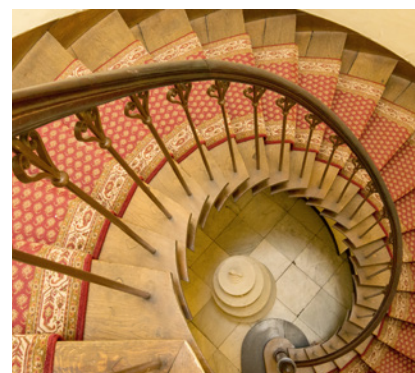
Le zoom 24-70 mm à 24 mm est suffisamment large pour cadrer un escalier en spirale et suffisamment long pour donner un bon aperçu du plancher.
